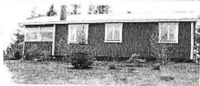
Tre av husen i övre byn Kölaråsen : Norstrands gård och vyn mot öster med Näsensjön i bakgrunden, under gamla stugan och Haurulas hus som ligger högst upp på berget. Dessa är året runt bebodda.
